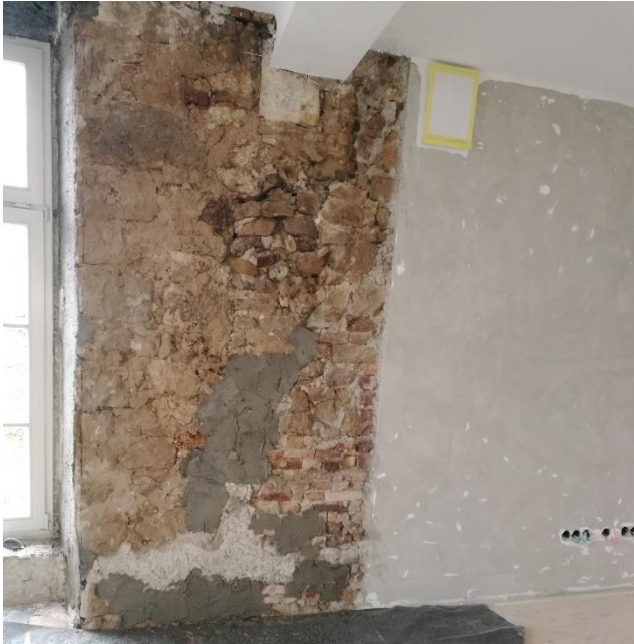
Abbildung 18: Abgenommener Bestandputz unter der Testfläche der Udi Reco Dämmung und eingebaute Messrohre an der Ostfassade unter der SLENTITE (oben rechts). Testfläche sowie unter Calostat (rechts). Aufgebrachte SLENTITE Platten (unten-links).
