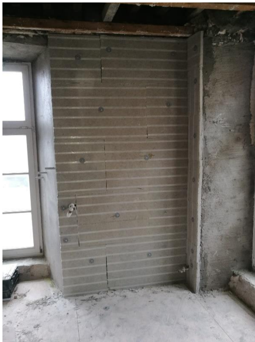
Abbildung 19: Montierte Calostat (links) und aufgetragene Aerobran (rechts) Testflächen
