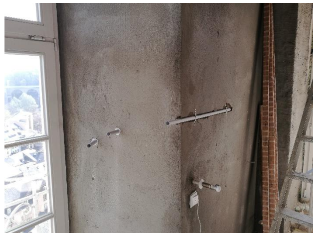
Abbildung 18: Abgenommener Bestandputz unter der Testfläche der Udi Reco Dämmung und eingebaute Messrohre an der Ostfassade unter der SLENTITE (oben rechts). Testfläche sowie unter Calostat (rechts). Aufgebrachte SLENTITE Platten (unten-links).
