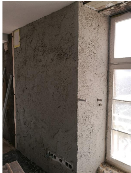
Abbildung 19: Montierte Calostat (links) und aufgetragene Aerobran (rechts) Testflächen
