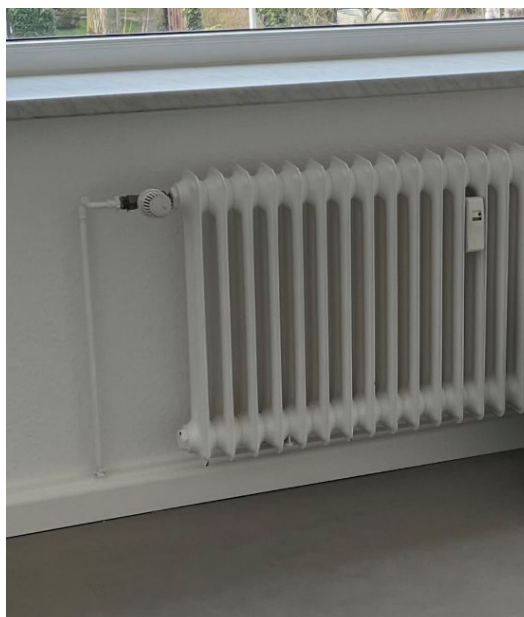
Abbildung 8: Elektronischer Heizkostenverteiler (links [54]) an Heizkörper in Testwohnung (rechts)
