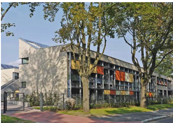
Abbildung 24: Südwestansicht der Grundschule Hohen Neuendorf [58].
