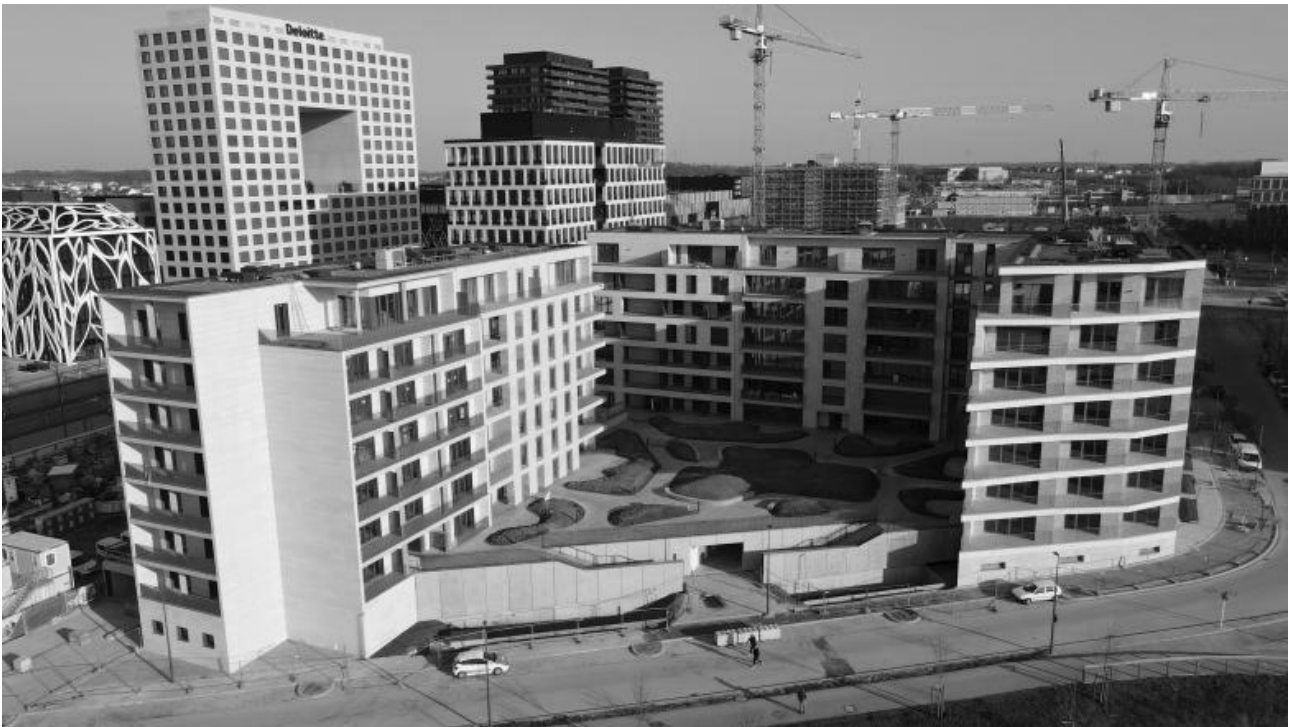
Abb. 2 Neubauprojekt „Îlot D Sud“ im Stadtviertel Cloche d’Or in Luxemburg Stadt
