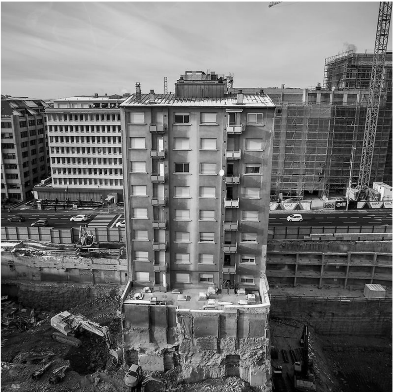
Abb. 1 Das Gebäude Nummer 49 auf dem Boulevard Royal in Luxemburg
