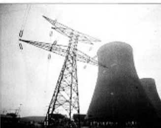
Une éolienne de haute tension sur le réseau électrique français, haute tension de 150 millions de volts environ.
