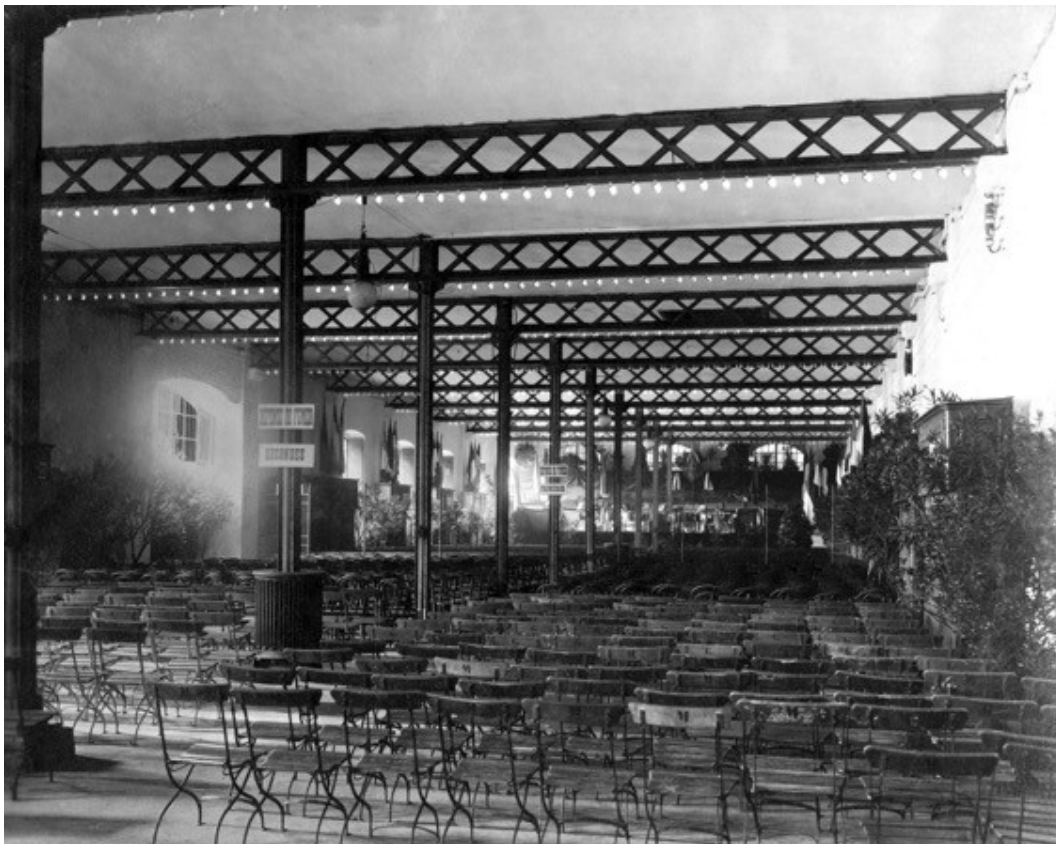
Abbildung 4 – Proberaum in dem Gebäude der Champagnerfabrik © - copyright Photothèque de la Ville de Luxembourg, Collection Mercier, salle concert
