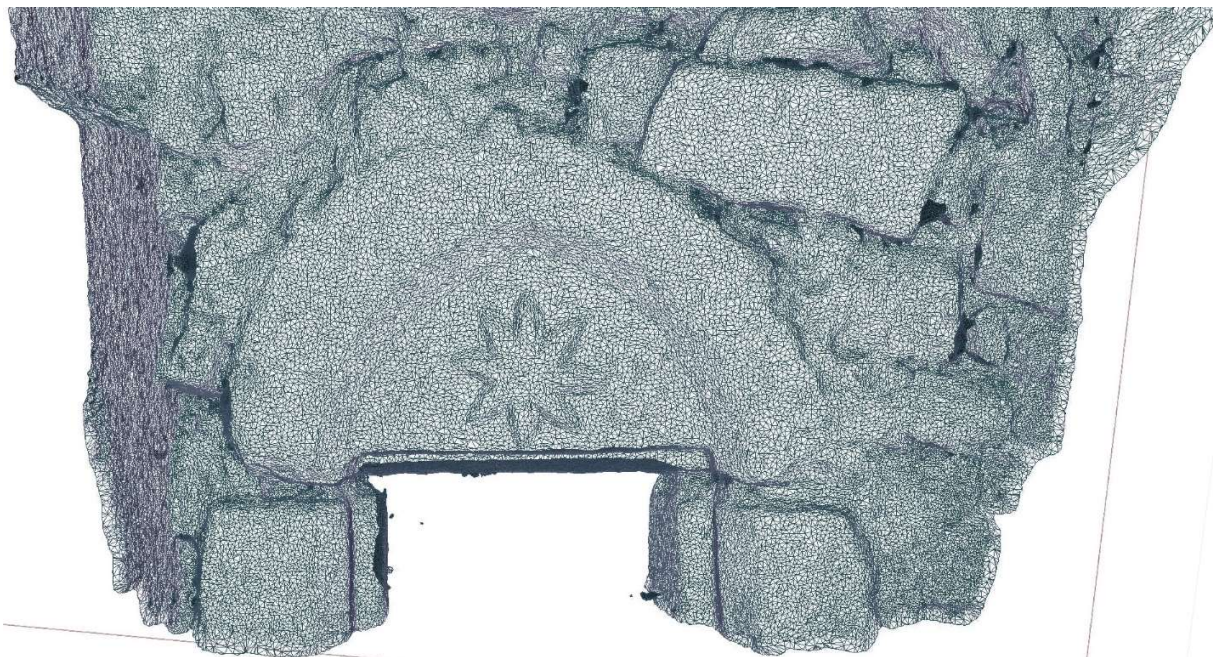
Abbildung 7 - Fotogrammetrische Aufnahme des gleichen Architekturdetails als 3D-Oberfläche
