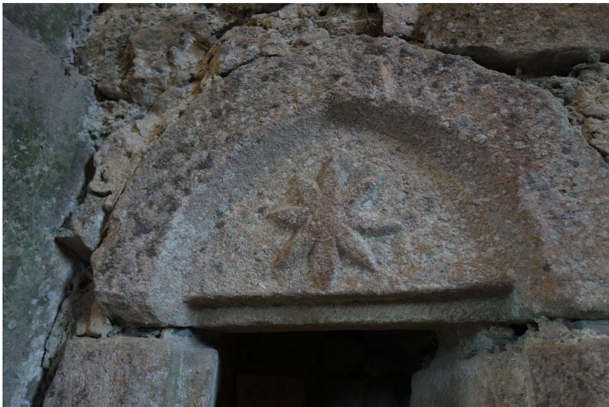
Abbildung 6 - Fotografie eines verzierten Sturzes im Criechinger Haus
