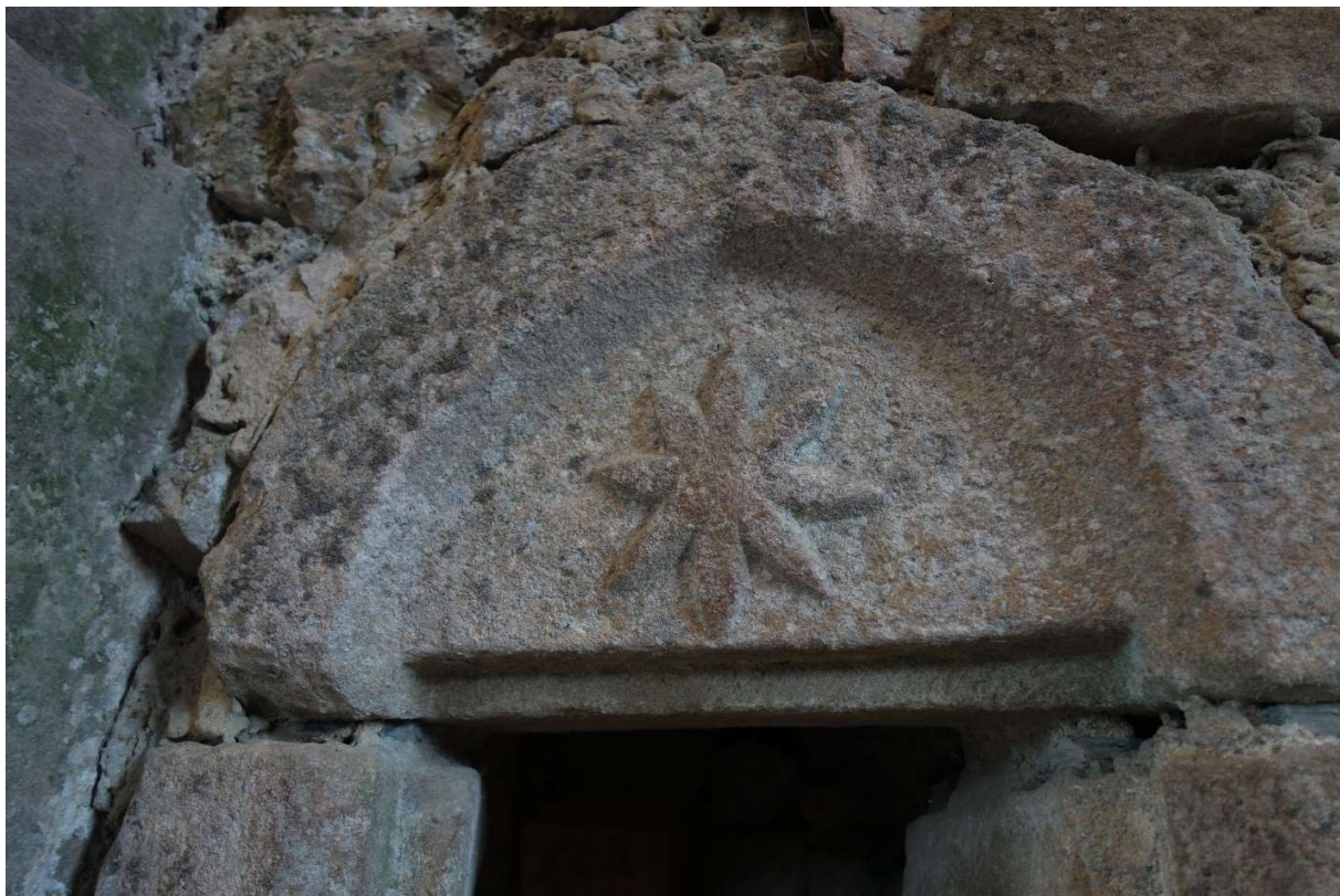
Abbildung 6 - Fotografie eines verzierten Sturzes im Criechinger Haus
