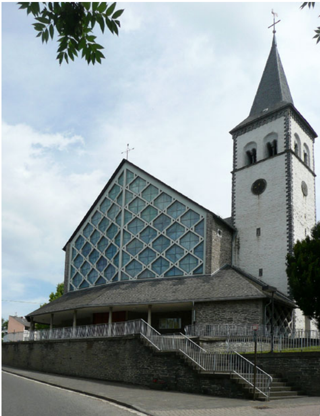
Ochtendung, St. Martin, agrandissement de l'ancienne église du village, Alfons Leidl 1958
