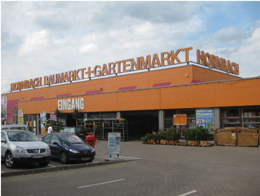
Hornbach à Sarrebruck, grande surface de bricolage
