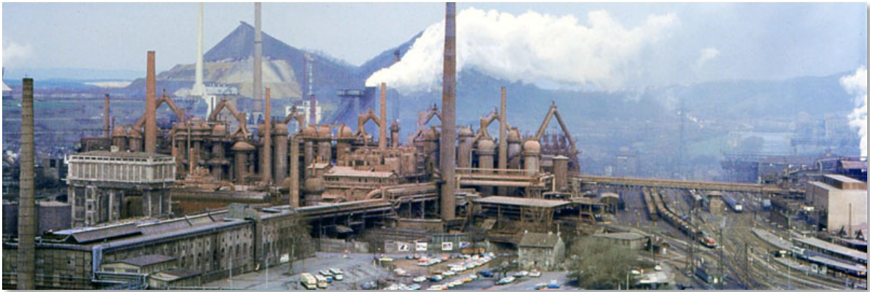
Complexe de hauts-fourneaux en 1986, peu avant la cessation des activités, avec entre autres 6 hauts-fourneaux, y compris les réchauffeurs d'air, le château d'eau (à gauche), soufflante à gaz (au premier plan), vestiges de l'ancienne aciérie (à droite) et les crassiers (en arrière-plan). Photo : N. Mendgen
