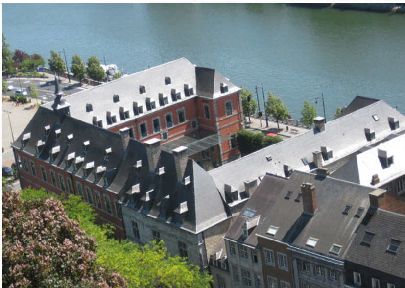
Grand Hôpital de Namur, fondé en 1270. Aujourd'hui le bâtiment est le siège du gouvernement régional de la Wallonie. Photo : T. Chilla 2010
