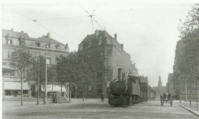
Chareli remonte l'actuelle avenue de la Liberté. Photo prise en septembre 1928 juste avant le remplacement des trains à vapeur par des motrices électriques entre les gares de Luxembourg et de Dommeldange.
