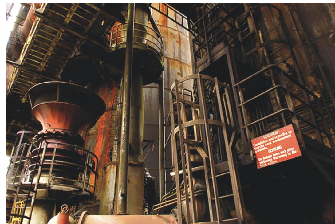
Ce qui intriguera le futur visiteur, c'est cette combinaison de tuyaux, de conduites, de planchers, de cages d'escaliers, de niveaux. Autant d'éléments "secondaires" à sauver de la phobie de Monsieur Propre (Photo : Lex Kleren).
