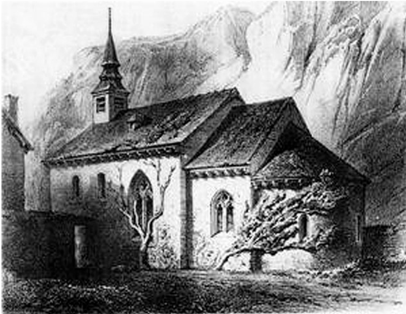
"Eglise des Malades hors la ville", Namur, errichtet 1153
