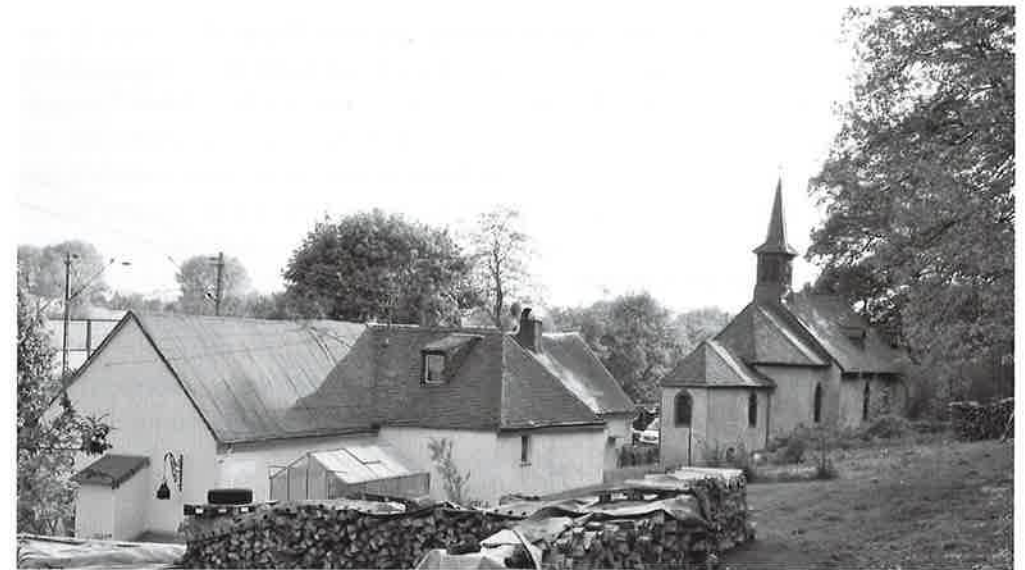
Abb. 2: Das ehemalige Trierer Leprosorium St. Jost. Im Vordergrund die Wohn- und Wirtschaftsgebäude, im Hintergrund die Kapelle mit doppelt gestaffelter Apsis und Dachreiter, in: UHRMACHER, Lepra (wie Anm. 1), S. 338.
