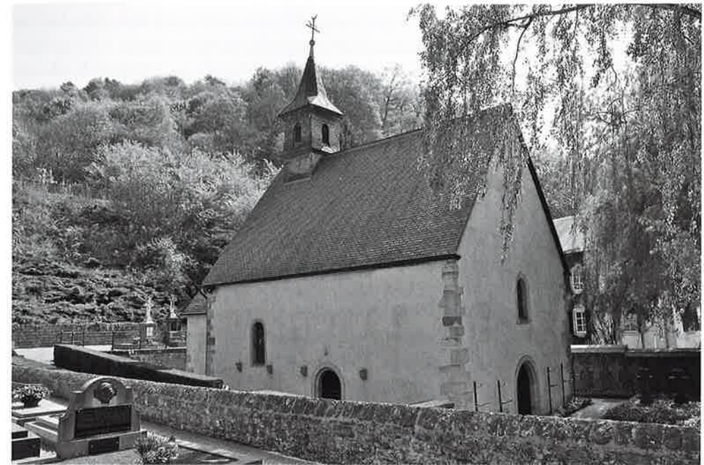
Abb. 4: Kapelle des ehemaligen Luxemburger Leprosoriums. Es handelt sich um einen einschiffigen Bau mit rechteckiger Apsis und einem Dachreiter. Die Kapelle wurde 1982 umfassend renoviert und dient heute als Friedhofskapelle, in: UHRMACHER, Lepra (wie Anm. 1), S. 337.
