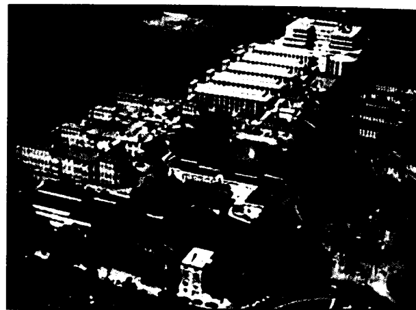
Figuur 5. Het Brugmannziekenhuis te Brussel (luchtfoto).
